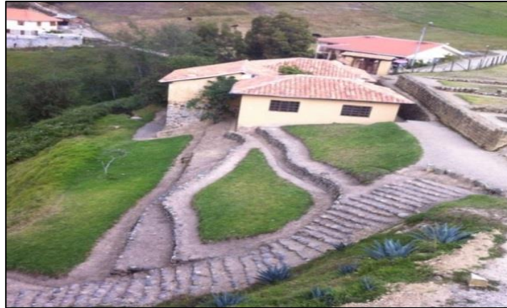
Figura 1.16 Escalinatas del Barranco
