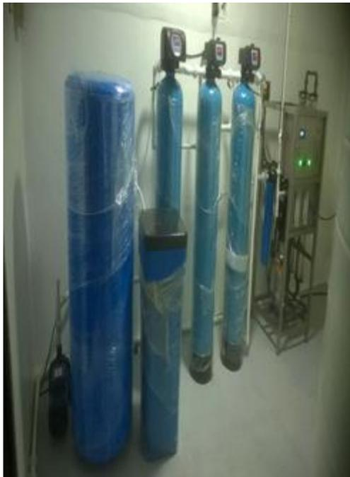
Orden de la imagen de izquierda a derecha Bomba, tanque de presión, reservorio de sal en grano, filtros de (el proceso inicia desde el filtro de la derecha) resina, carbón activado, ablandador. Máquina de ósmosis inversa
