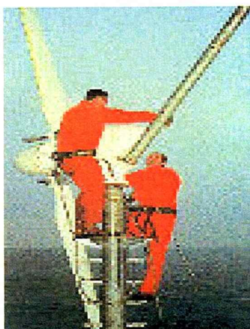
Fig. No. 3.18 Mantenimiento en un aerogenerador
