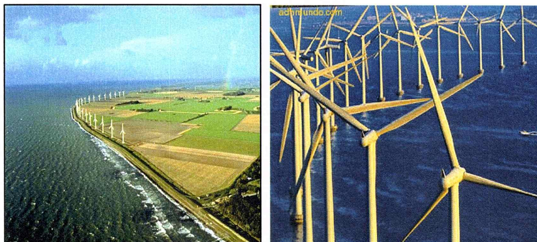
Fig. No. 3.3 Parque eólico en un perfil costanero y “off Shore”
