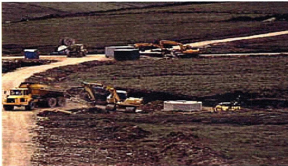
Fig. No. 3.11 Construcción de una torre
