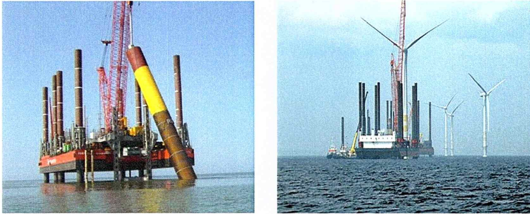
Fig. No. 3.5 Sembrado de bases para parque eólico “Off Shore” (Alemania)
