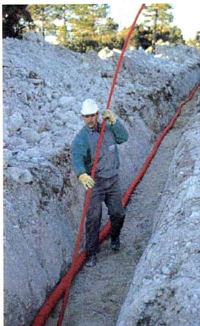
Fig. No. 3.16 Tendido del cableado subterráneo
