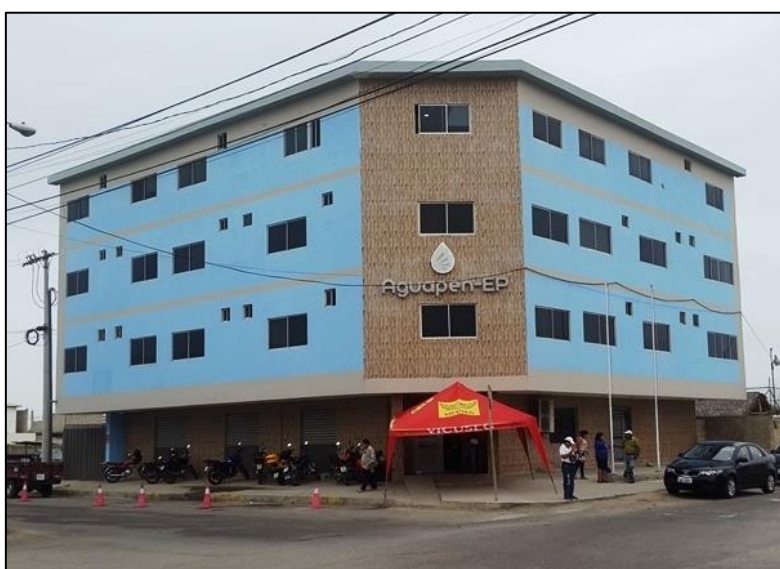
Foto 2: Edificio administrativo de la empresa Aguapen-EP.
