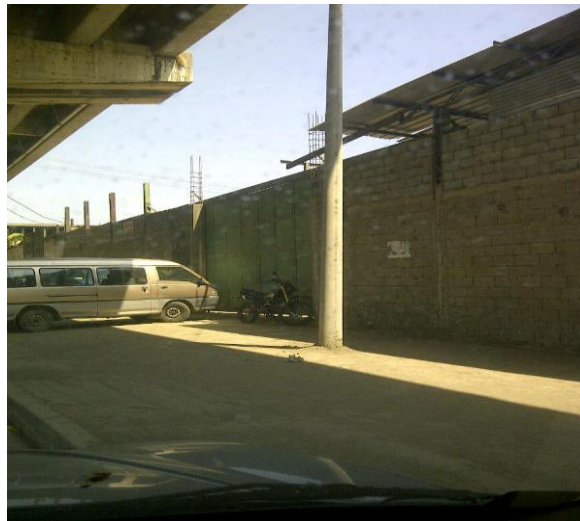
Ilustración 26 Instalaciones exteriores de la planta
