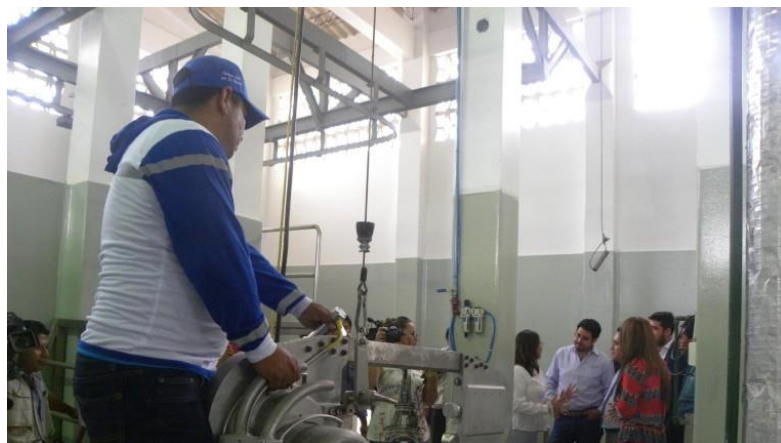
Figura 1.1: Instalaciones del Camal
